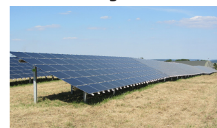
Les panneaux sont posés au sol
