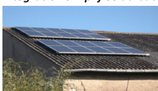
Les panneaux sont posés sur les tuiles
