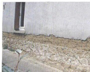
Saignée de sauvetage sur une maison du Gers en briques de terre crue (adobe) isolée conventionnellement par l'intérieur et enduite au ciment.
