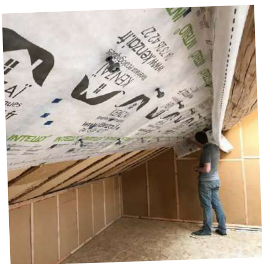
POSE DU PARE-VAPEUR PAR UN PARTICULIER HABITANT À NANCY
