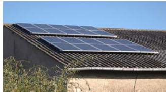
Les panneaux sont posés sur les tuiles
