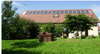
Les panneaux remplacent les tuiles
