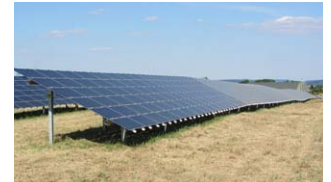
Les panneaux sont posés au sol
